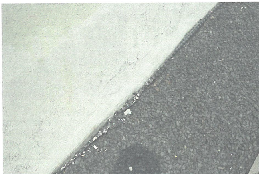
Fot. 13. Odstająca folia kubełkowa, sprzyja przedostawaniu się wody rozbryzgowej i rozwojowi glonów
