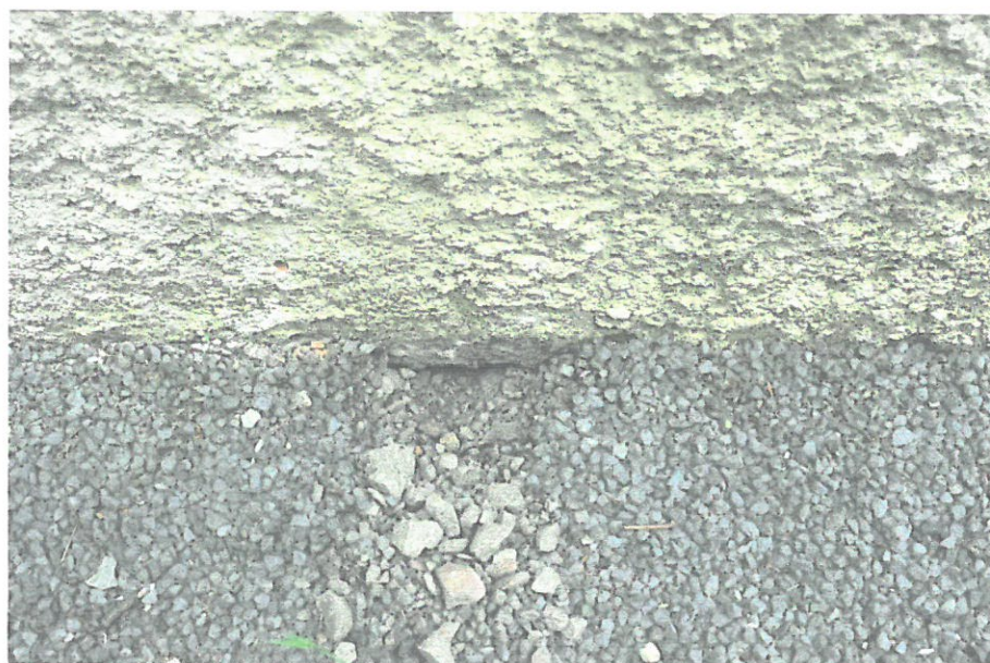
Fot. 4. Miejsce odkrywki C, widoczny brak izolacji i glony
