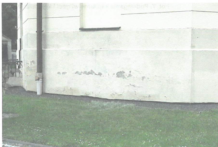
Fot. 10. Zawilgocenie i zasolenie cokołu oraz widoczna strefa odparowania wilgoci
