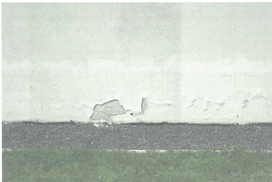
Fot. 9. Zawilgocenie i zasolenie cokołu
