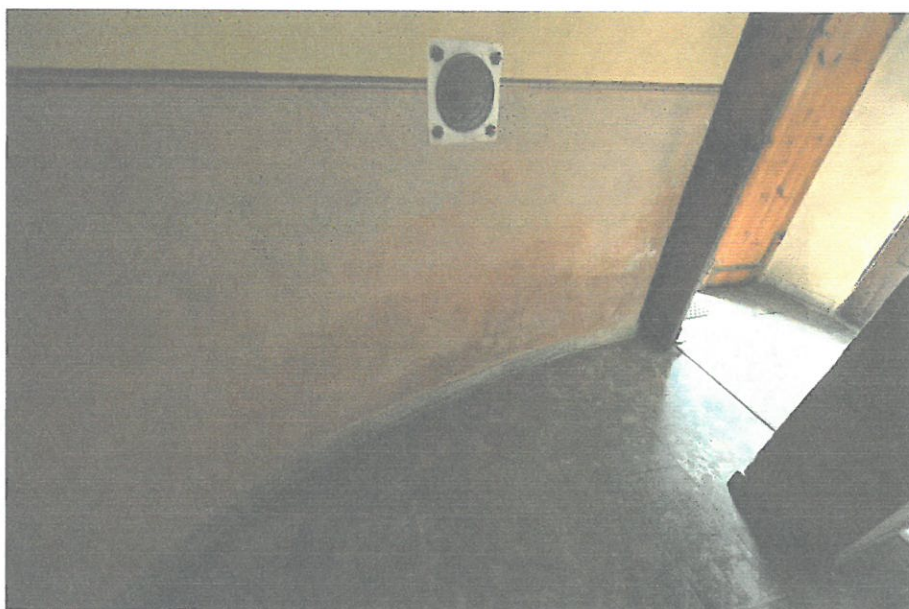
Fot. 12. Korozja chemiczna, widoczne zawilgocenia i krystalizacja soli
