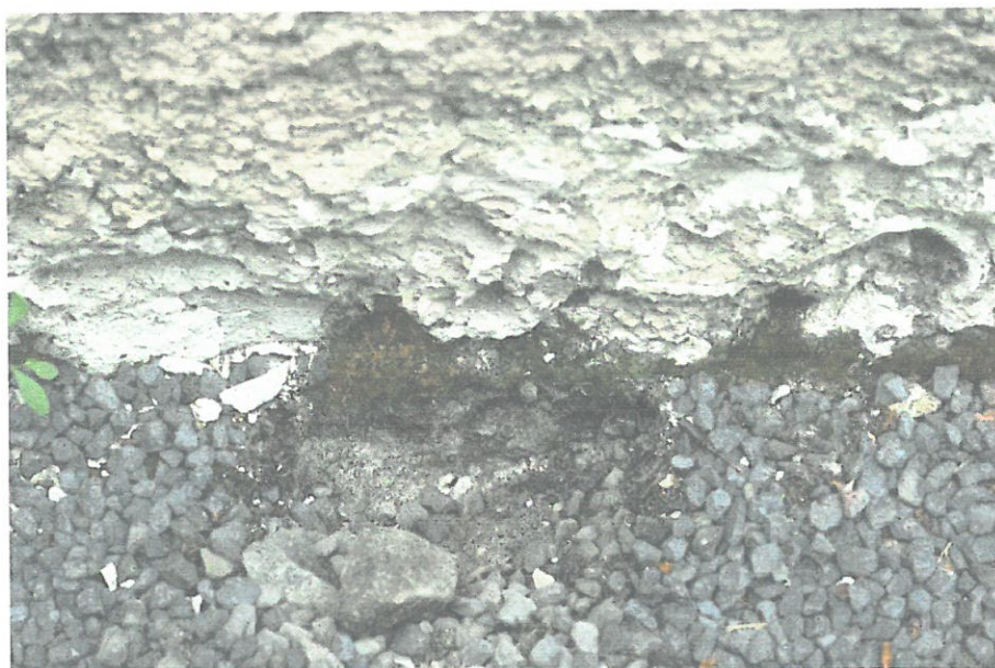
Fot. 5. Miejsce odkrywki D, widoczny brak izolacji, rozwój glonów i porostów
