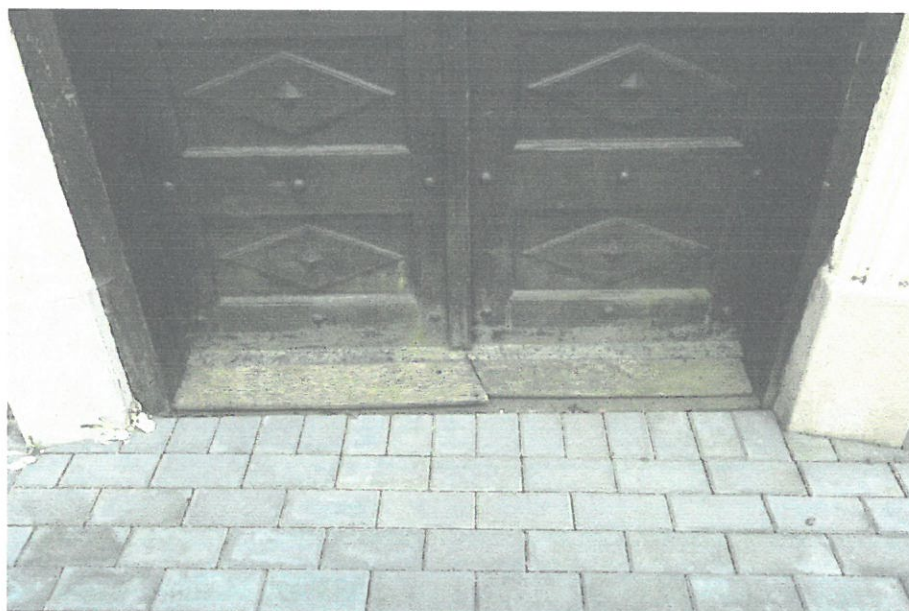
Fot. 11. Porażenie biologiczne glonami drzwi
