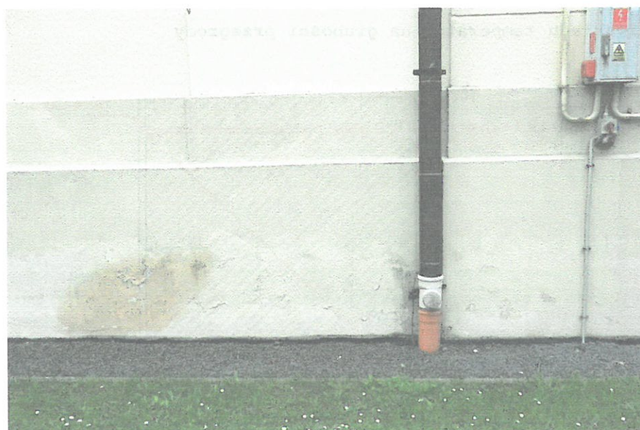
Fot. 2. Zawilgocenie i zasolenie cokołu oraz widoczna strefa odparowania wilgoci
